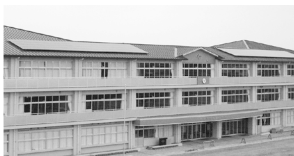
太陽光発電システムパネル
